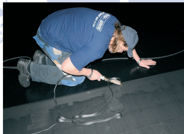
Aplikace pogumování Rubber lining application
