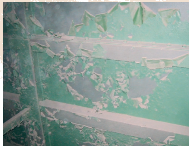
Starý nátěrový systém - interiér mostu Previous paint procedures - interior bridge
