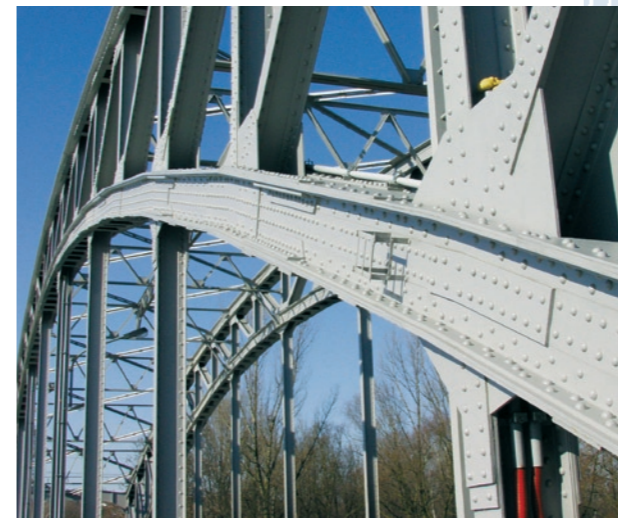
Most Petřkovice Petřkovice bridge
