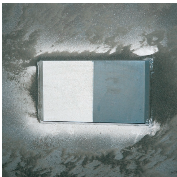
Detail rozdílu metalizace/ otryskaný povrch Detail difference of metallization/ blasted surface
