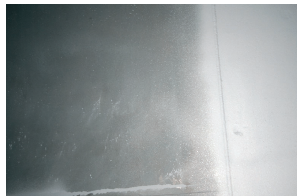
Detail rozdílu metalizace/ otryskaný povrch Detail difference of metallization/ blasted surface
