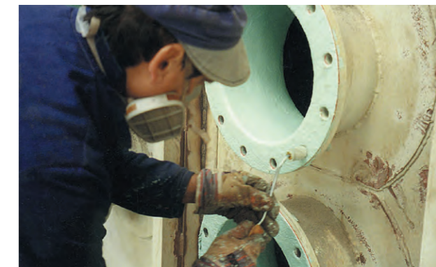
Detail stěrky na přírubě Detail of gravel on flange
