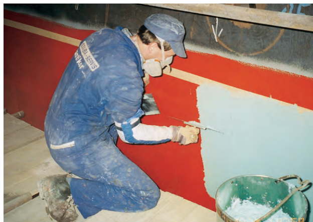
Aplikace stěrky Gravel application
