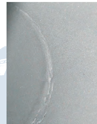
Otryskaný povrch potrubí Blasted pipe surface
