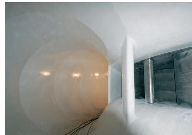
Povrstvení spirály (vodní elektrárna Dalešice) Spiral coat application (water power plant Dalešice)
